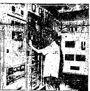
Một khu trong nhà máy phát lân sông điện ngân.
