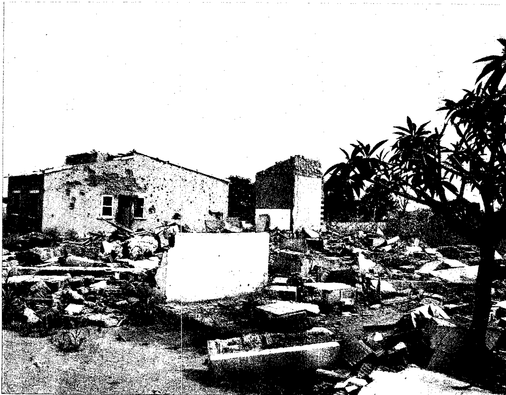
Cuvelai - Province of Cunene. Houses destroyed in March 1984 Cuvelai - Provincia de Cunene, casas destruidas en marzo de 1984.
