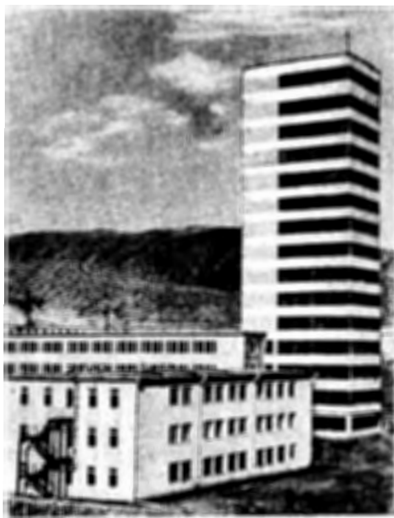
Рис. 1. Общий вид производственного корпуса с башенной частью
