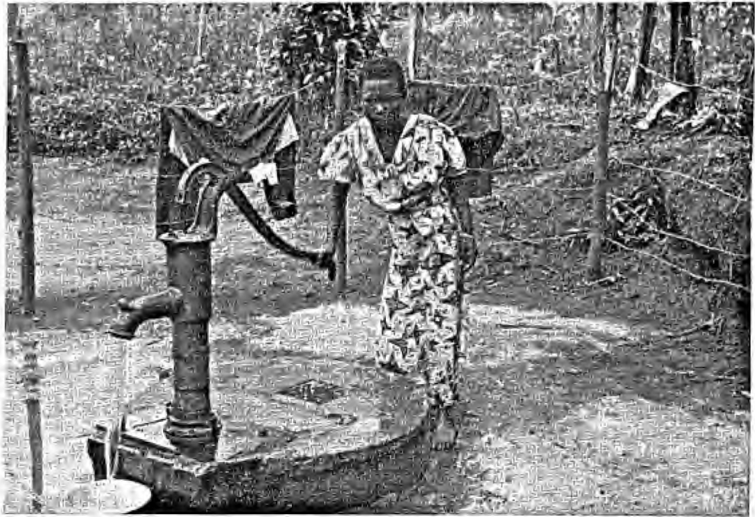
Kigali. — Seconde pompe aspirante.
