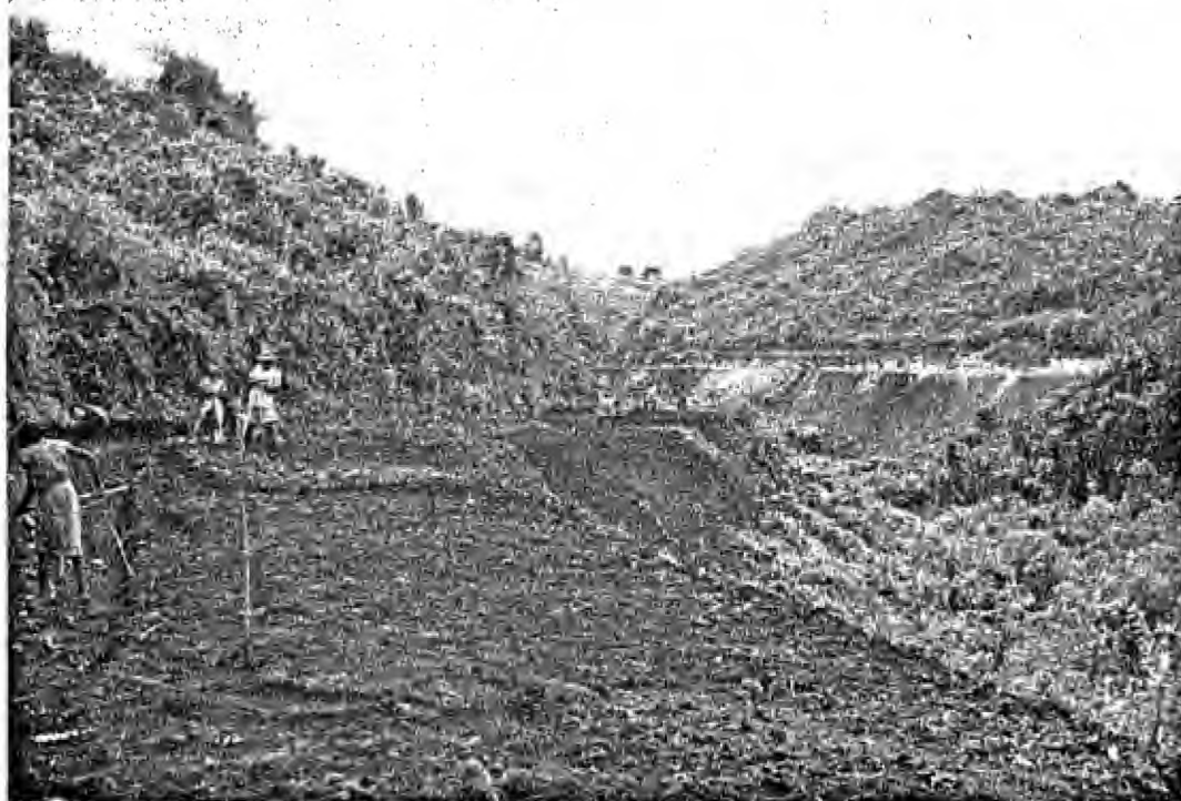
Aménagement de la plate-forme du race du Mulera (Ruhengeri).
