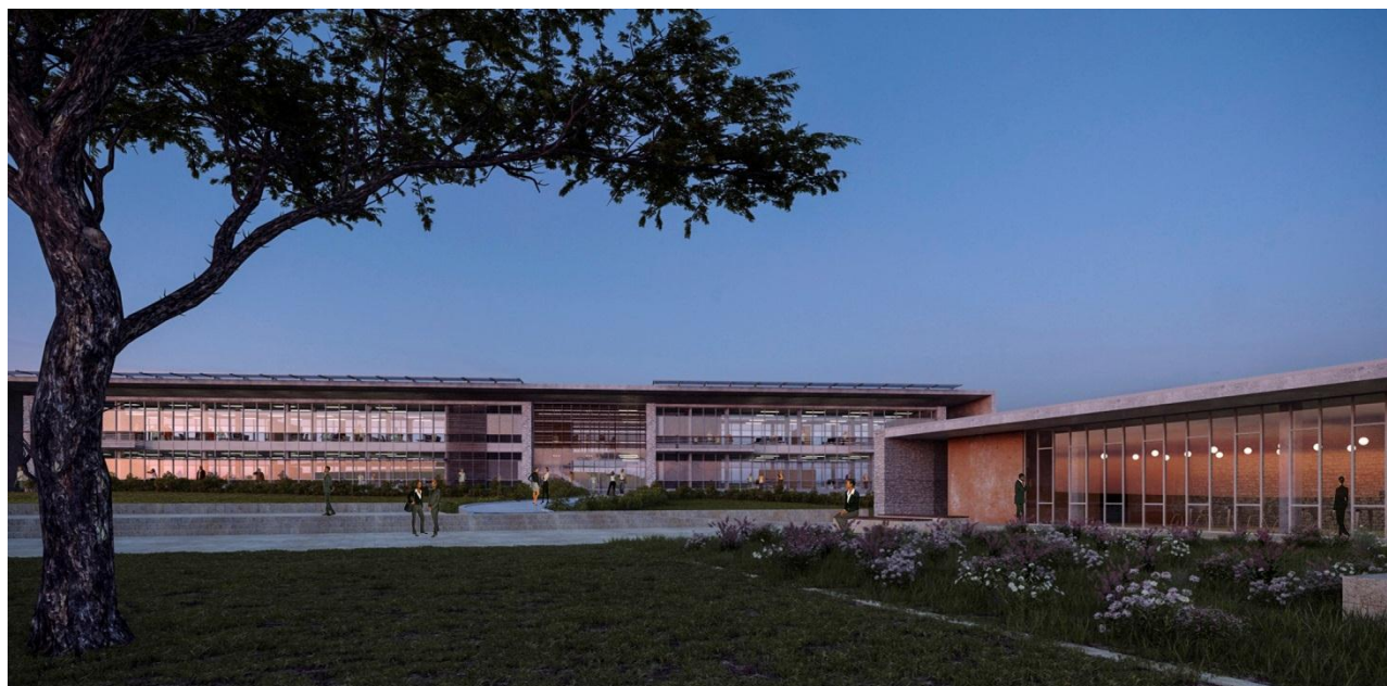
Вид на служебное здание и здание архива (юго-западное направление)
