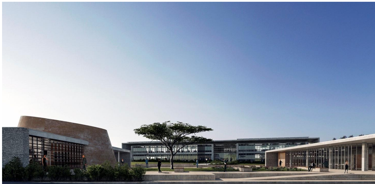
Вид на комплекс (южное направление)
