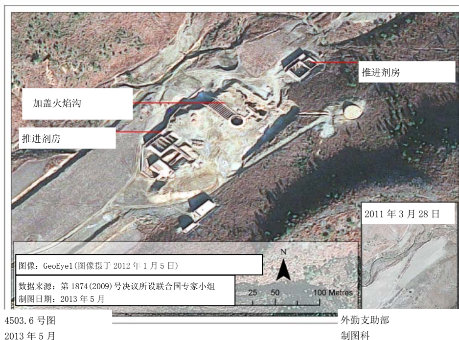
图七 东海设施正在建造的新发射架
