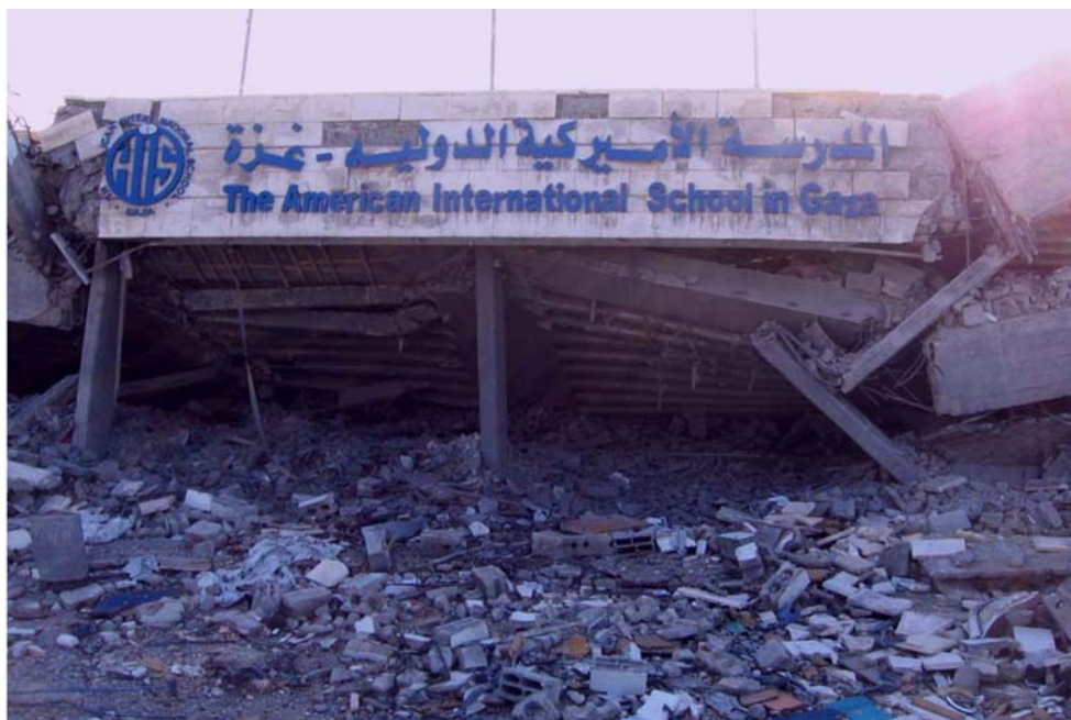
Foto 9: Restos del edificio principal de la Escuela Americana visto desde la calle.
