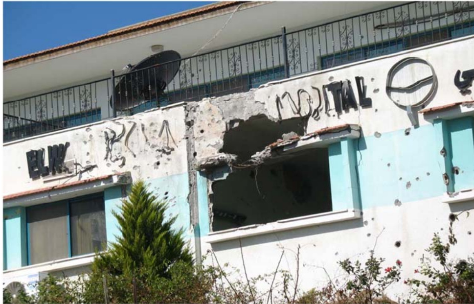
Foto 5: Daños en el hospital Al-Wafa. Son visibles las letras “EL W ... AL”.
