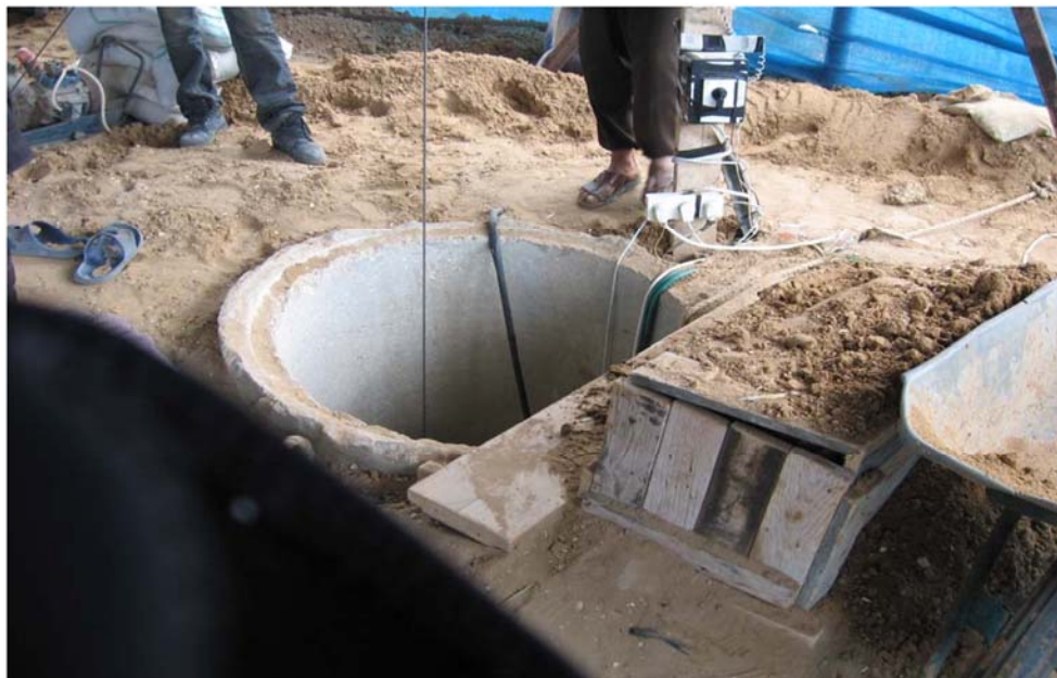
Foto 25: Uno de los túneles observados por el Comité.
