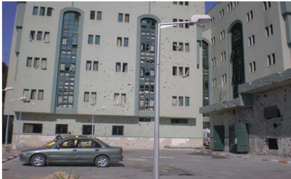
Foto 6: Daños en los edificios nuevos del hospital Al-Wafa.
