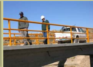
Infraestructura vial: •Mejoramiento y ampliación de carreteras y puentes
