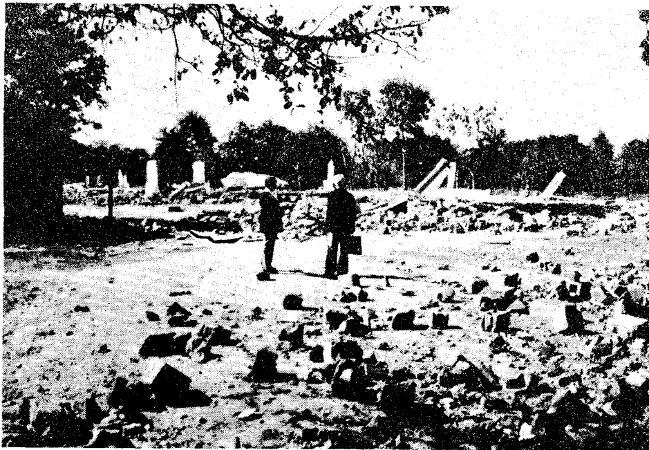
Разрушения в Малаи: общий вид
