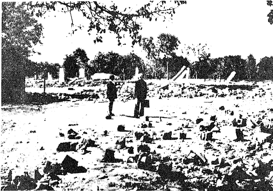
Destruction de Mapai : vue générale
