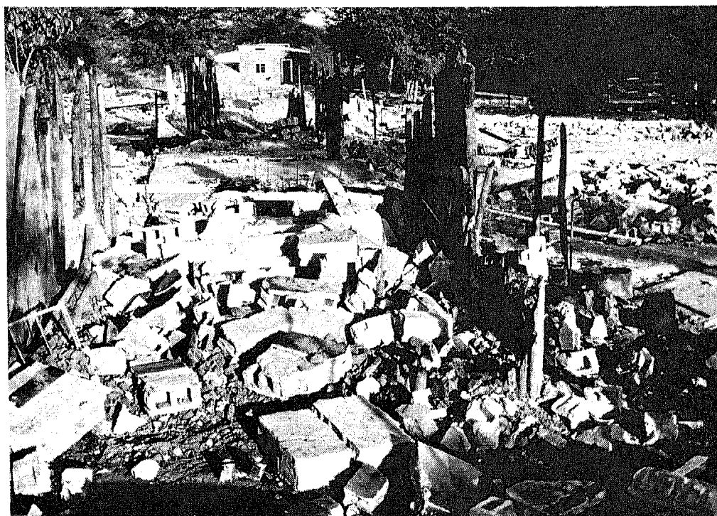
Cet amas de débris et de briques est ce qui reste du bâtiment où était installé le bureau de poste.
