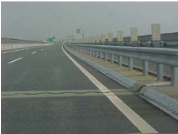
Pont autoroutier traversant la baie de Tokyo (aqualine)
