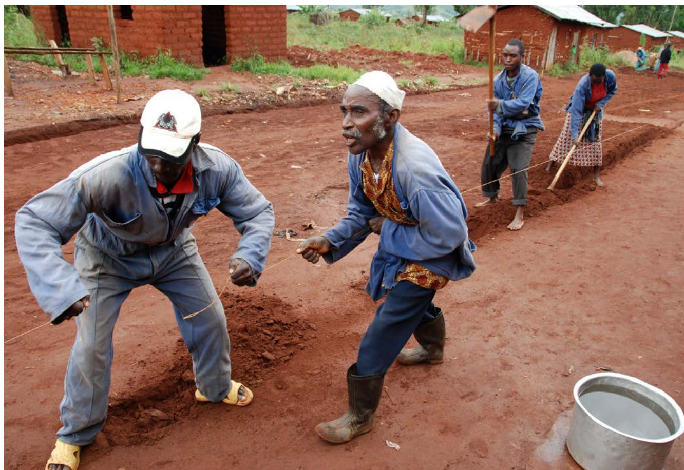
Des volontaires locaux travaillent ensemble pour construire une route pour leur communauté au Burundi (PNUD Burundi/Aude Rossignol, 2013).
