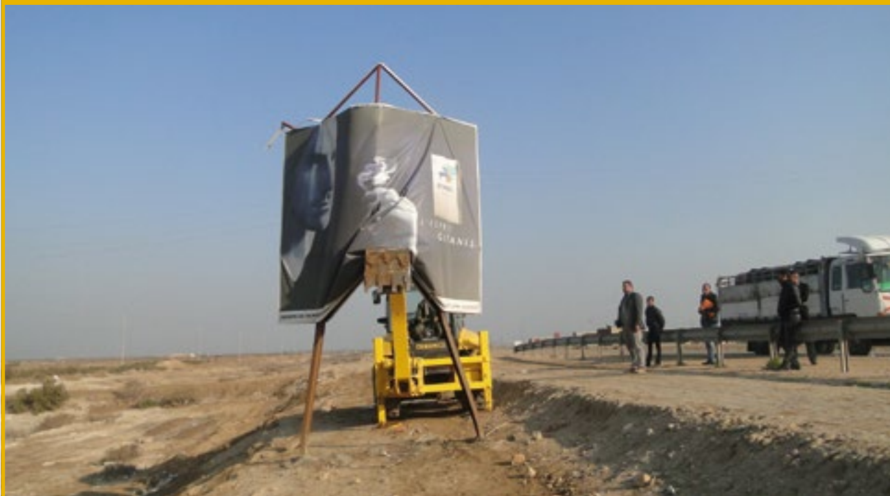
Una excavadora retira una valla publicitaria de una marca de cigarrillos.
