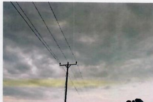
Domage sur la ligne électrique
