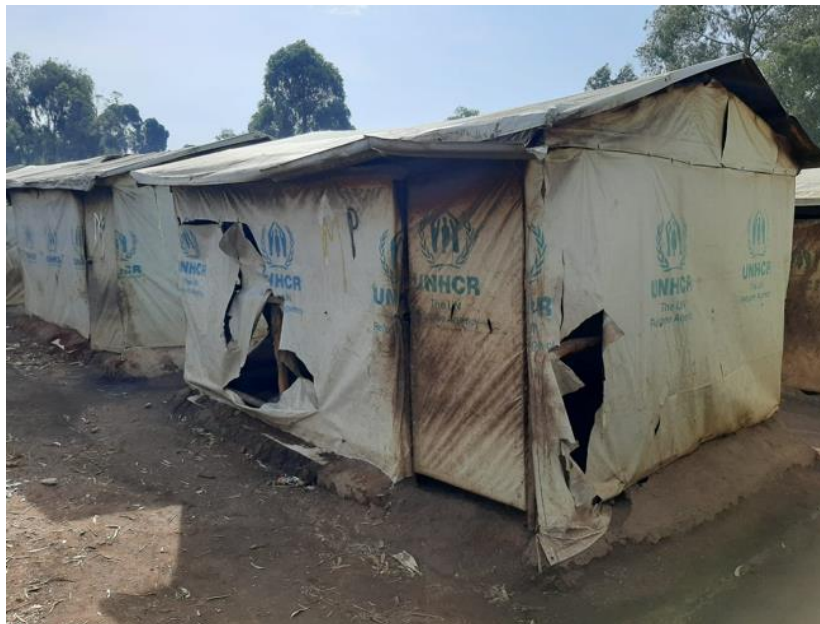
Shelters damaged during the attack according to IDPs Abris endommagés durant l'attaque selon les déplacés
