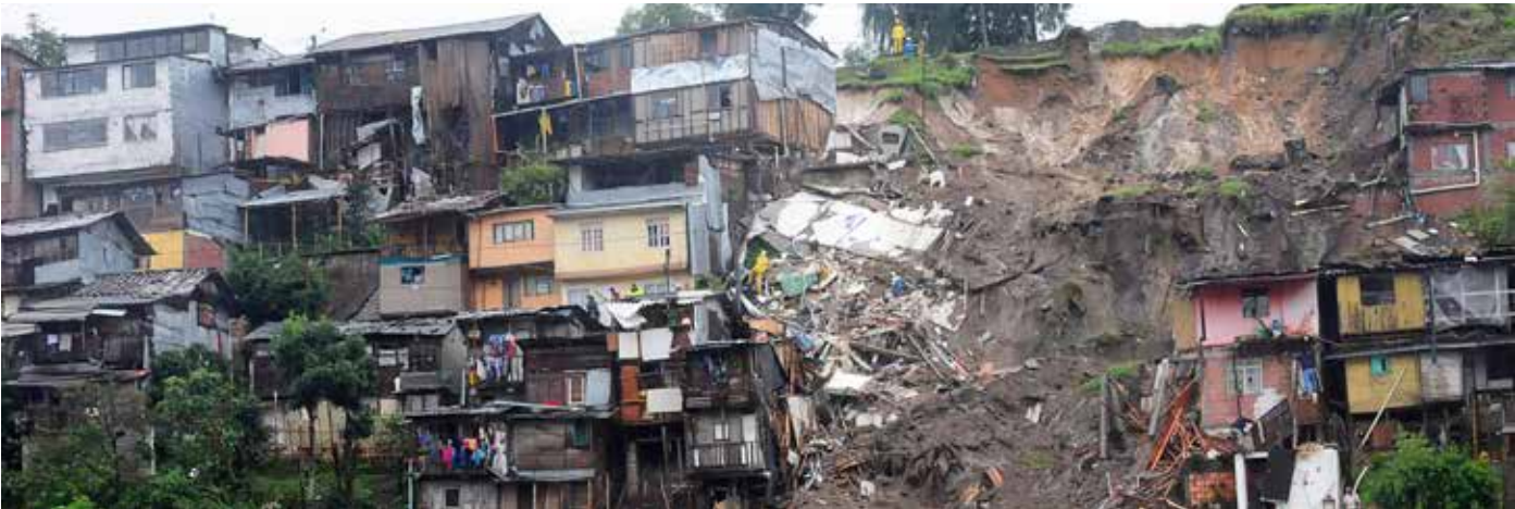
2017年4月19日（星期三）造成哥伦比亚马尼萨莱斯若干房屋被毁的滑坡现场图片。强降雨引发哥伦比亚山区咖啡种植区山体滑坡，造成至少七人死亡。（AP Photo/Maria Luisa Garcia）
