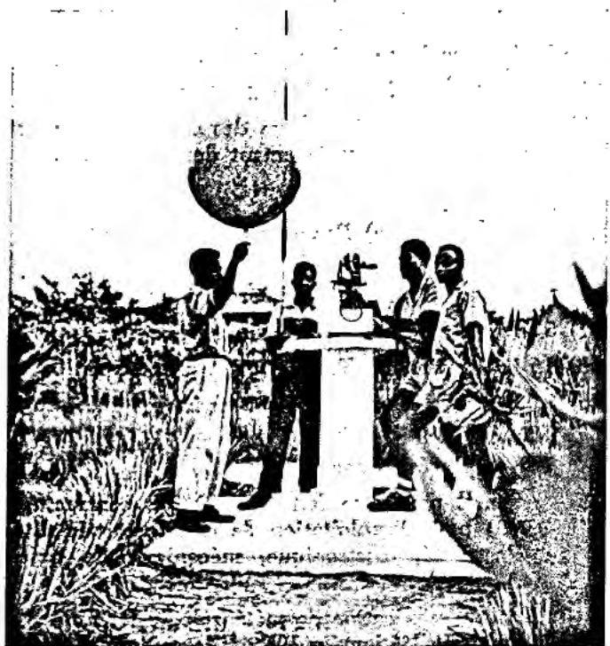
École d'application de météorologie de Douala. Élèves exécutant un sondage au théodolite.
