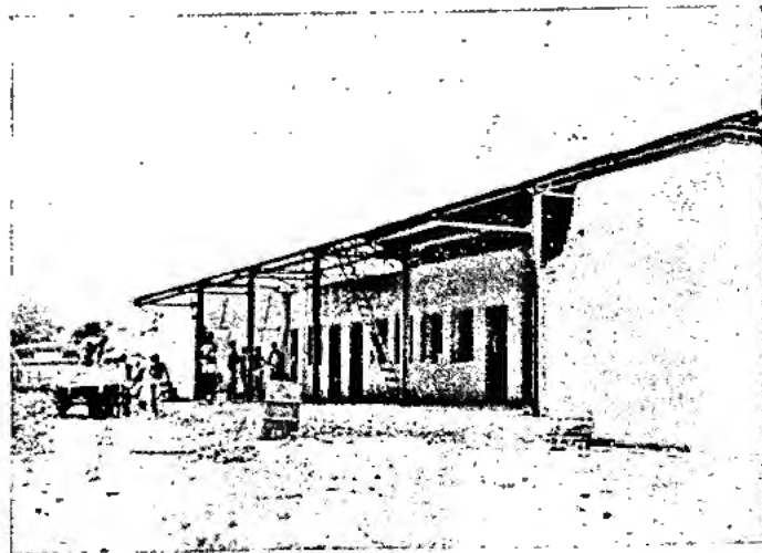
Chantier du dispensaire de Dukulla (mission catholique française).
