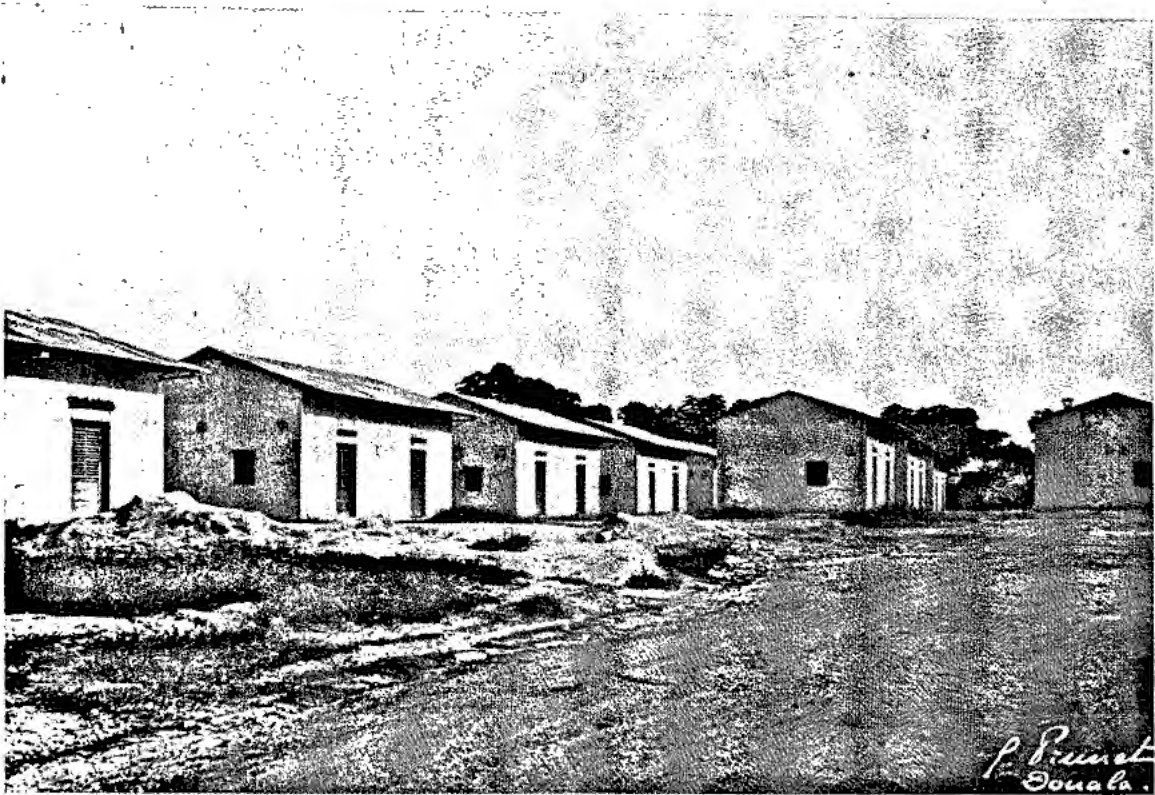
Nouvelle léproserie de Douala. Premier groupe de petits pavillons.
