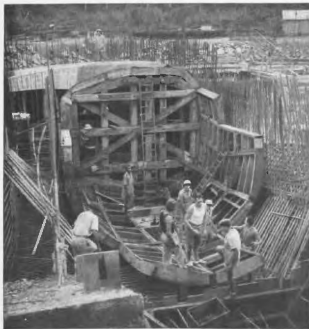
Barrage d'Édéa. Construction de la bâche spéciale.
