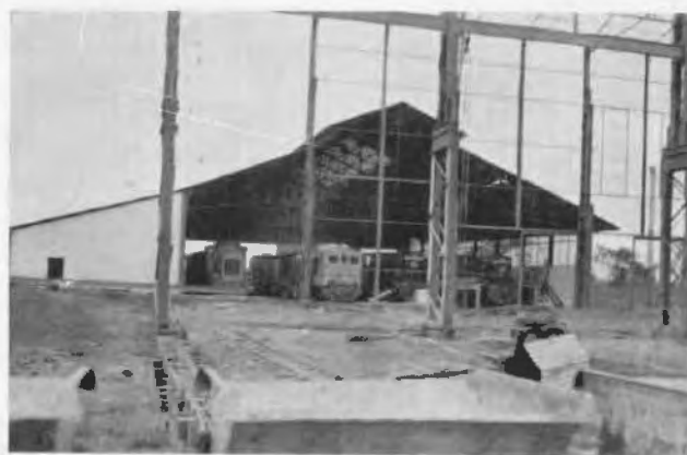
Le dépôt Diesel de Bassa.
