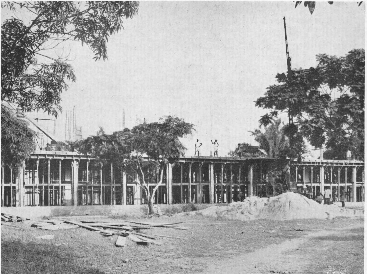
Hôpital Laquintinie : le chantier du 1 er pavillon à étages (80 lits)
