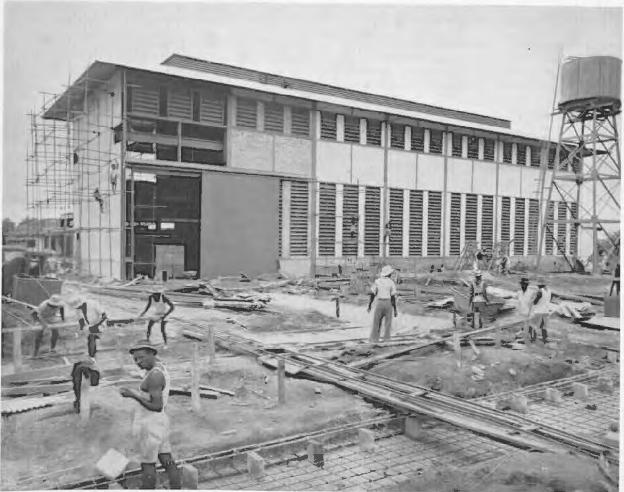
Construction de la centrale électrique de Bassa.
