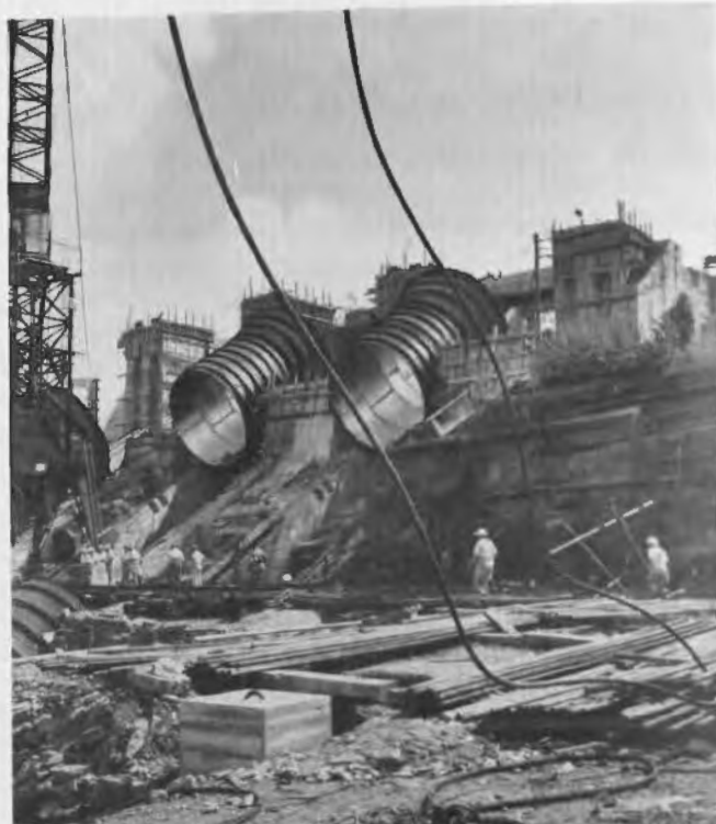
Barrage d'Edéa : amorce des conduites forcées.
