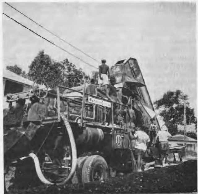
Bitumage à Douala.
