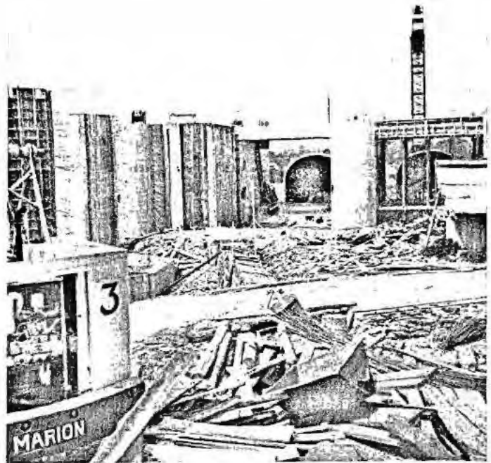
Barrage d'Édéa : amorce des conduites forcées.
