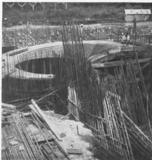
Barrage d'Édéa : construction de la bâche spéciale.
