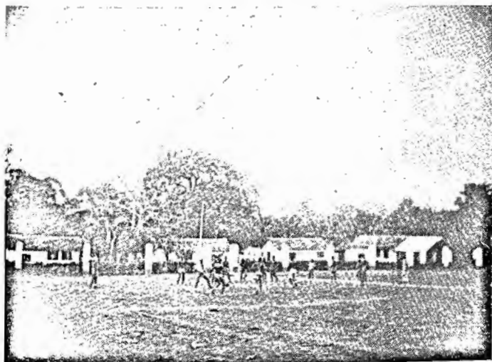
Centre de rééducation de l'enfance délinquante à Tové, vue générale, terrain de jeux et bâtiments.
