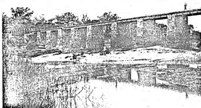
Pont sur la Kara.
