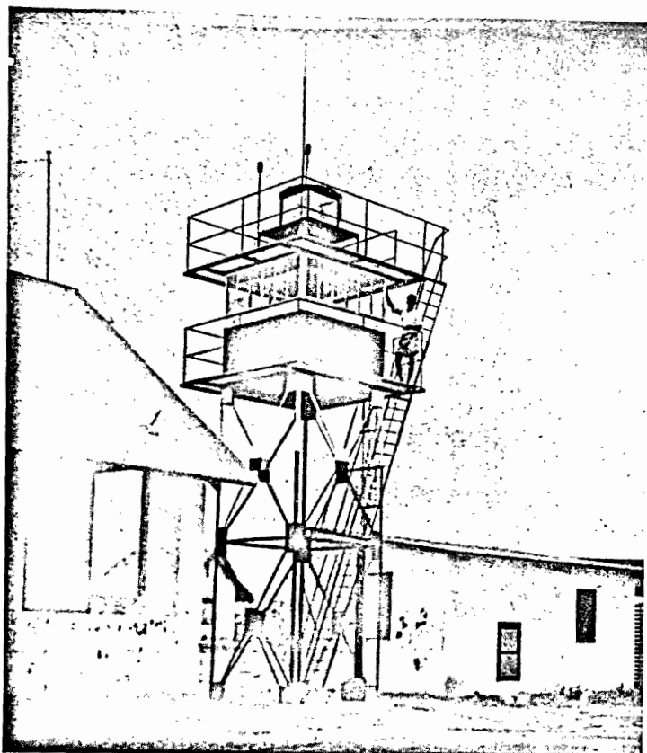
Aérodrome de Lomé. Tour de contrôle.
