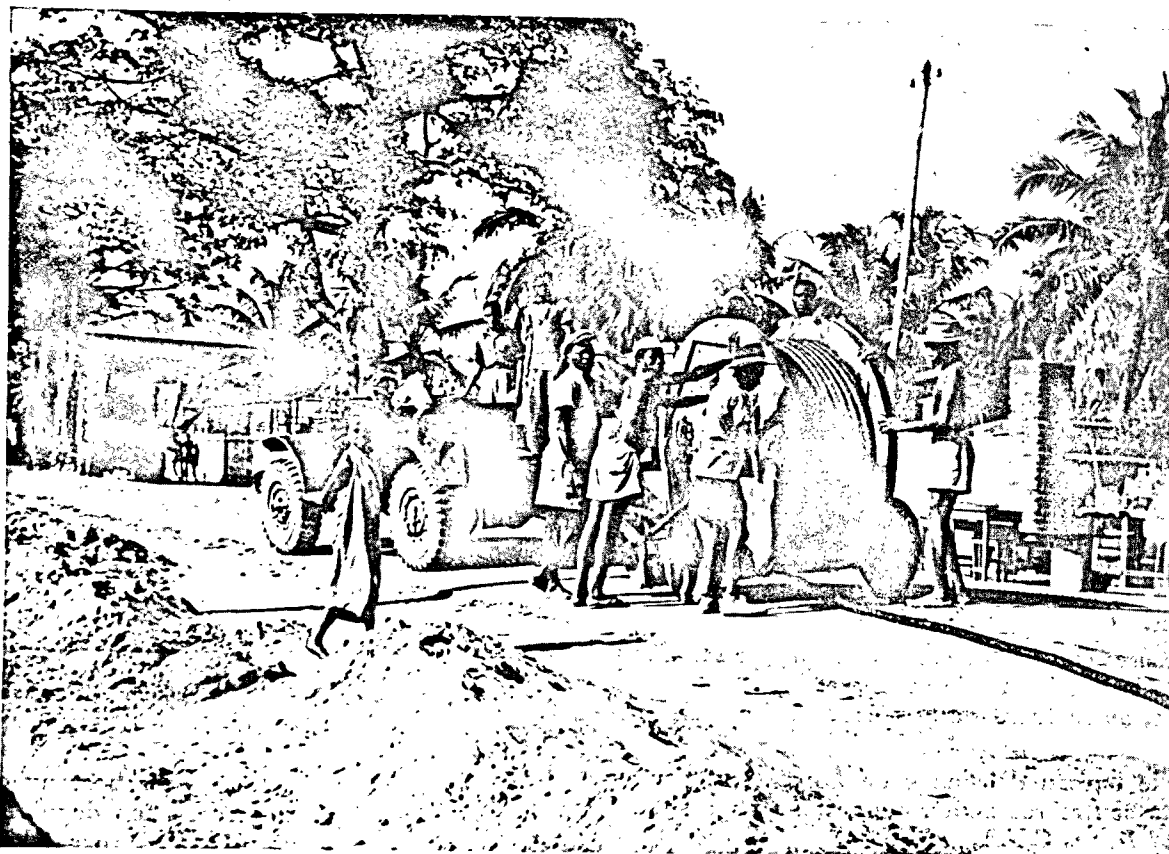
Pose des fils souterrains du téléphone automatique.
