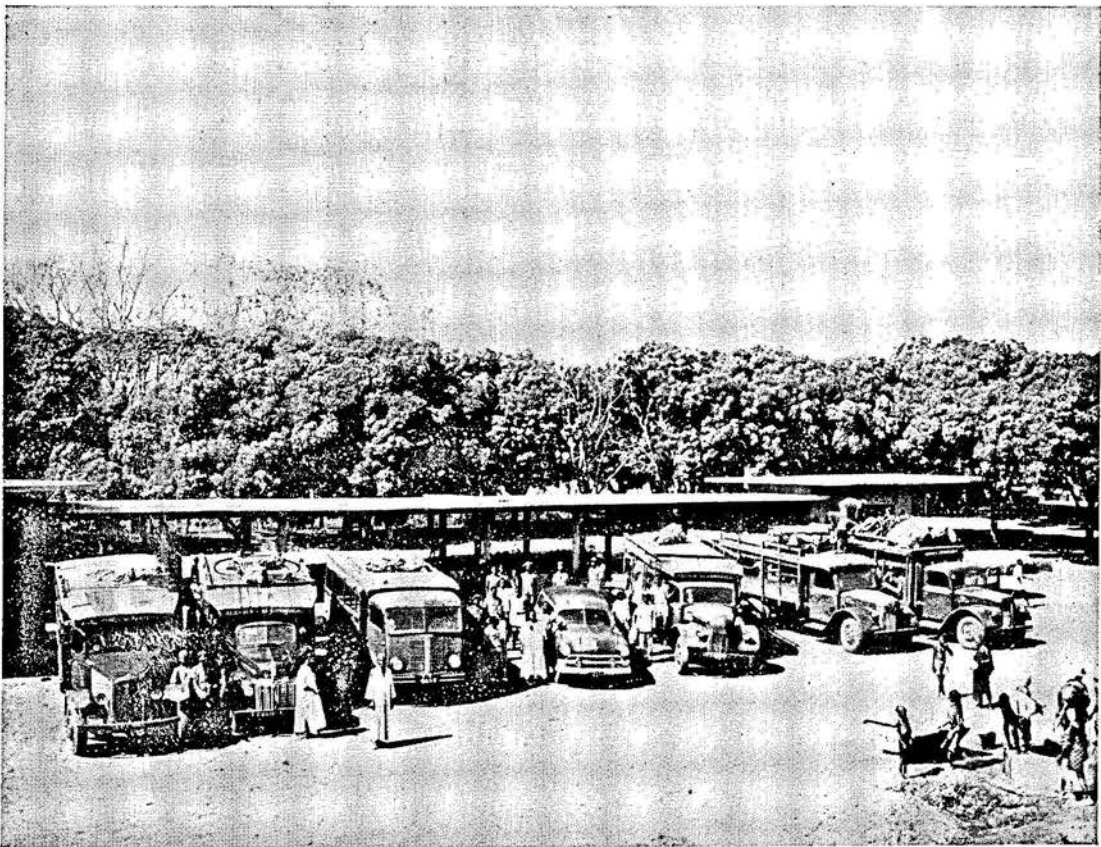
Gare routière de Sokodé.
