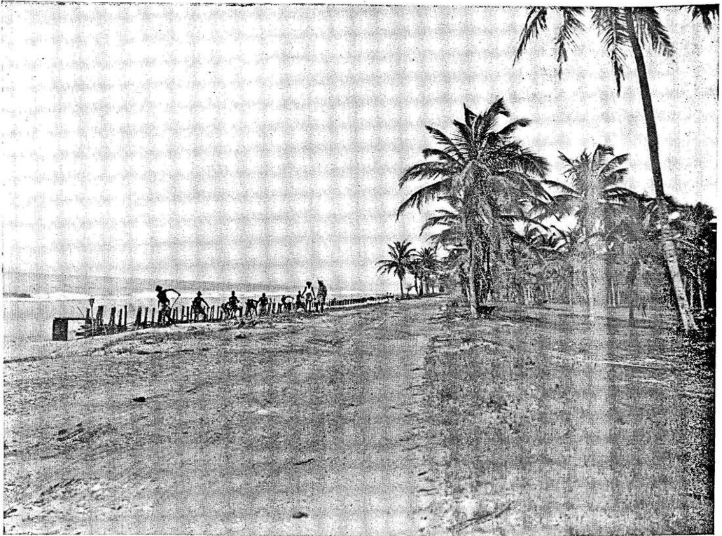
Route Lomé-Anécho avant bitumage.
