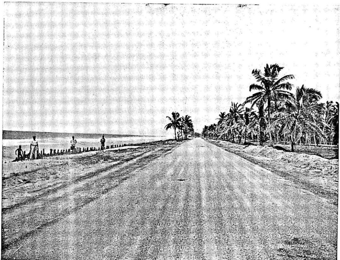
Route Lomé-Anécho après bitumage.
