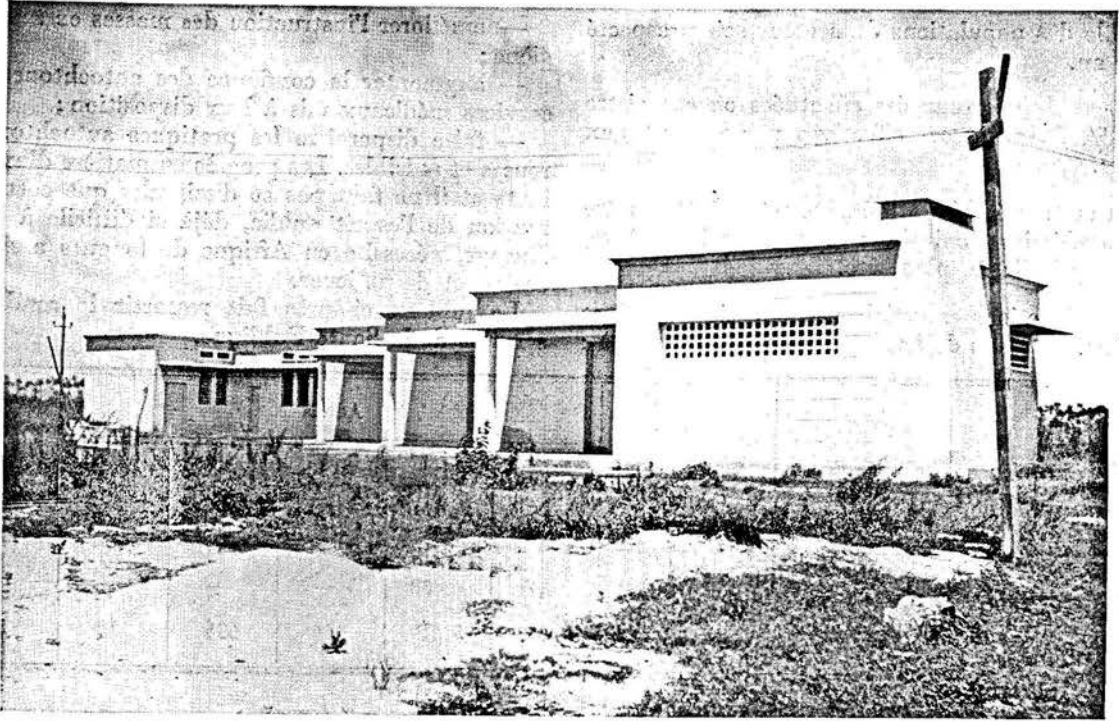
Hôpital de Lomé. — Magasins. Façades principales.
