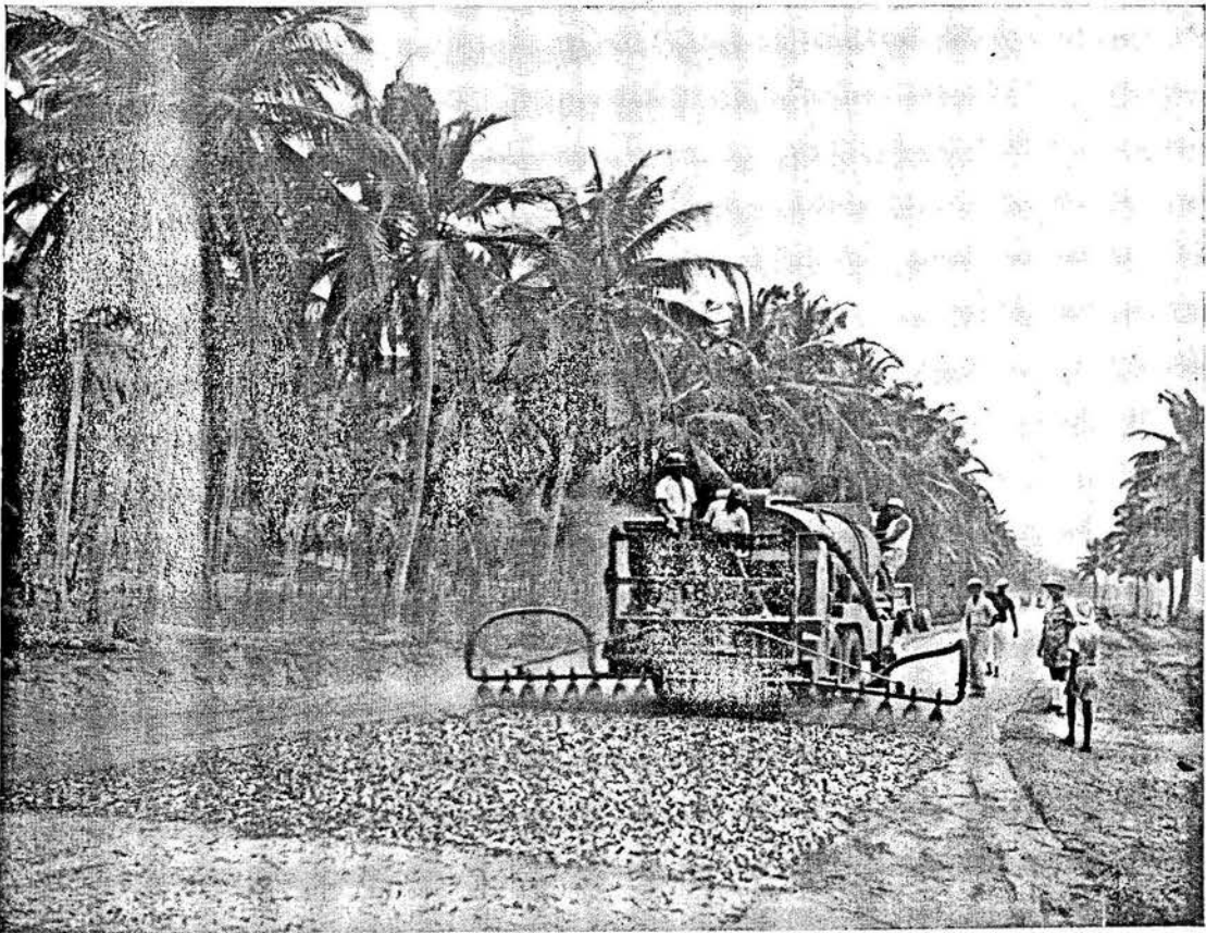
Route Lomé-Anécho. Bitumeuse de 3.500 litres au travail.
