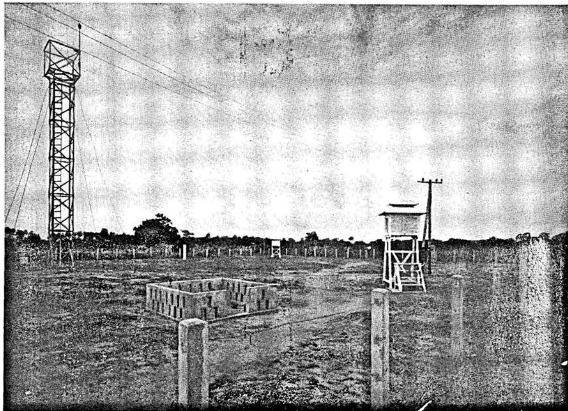
Station météo de l'aérodrome : Parc à instruments.
