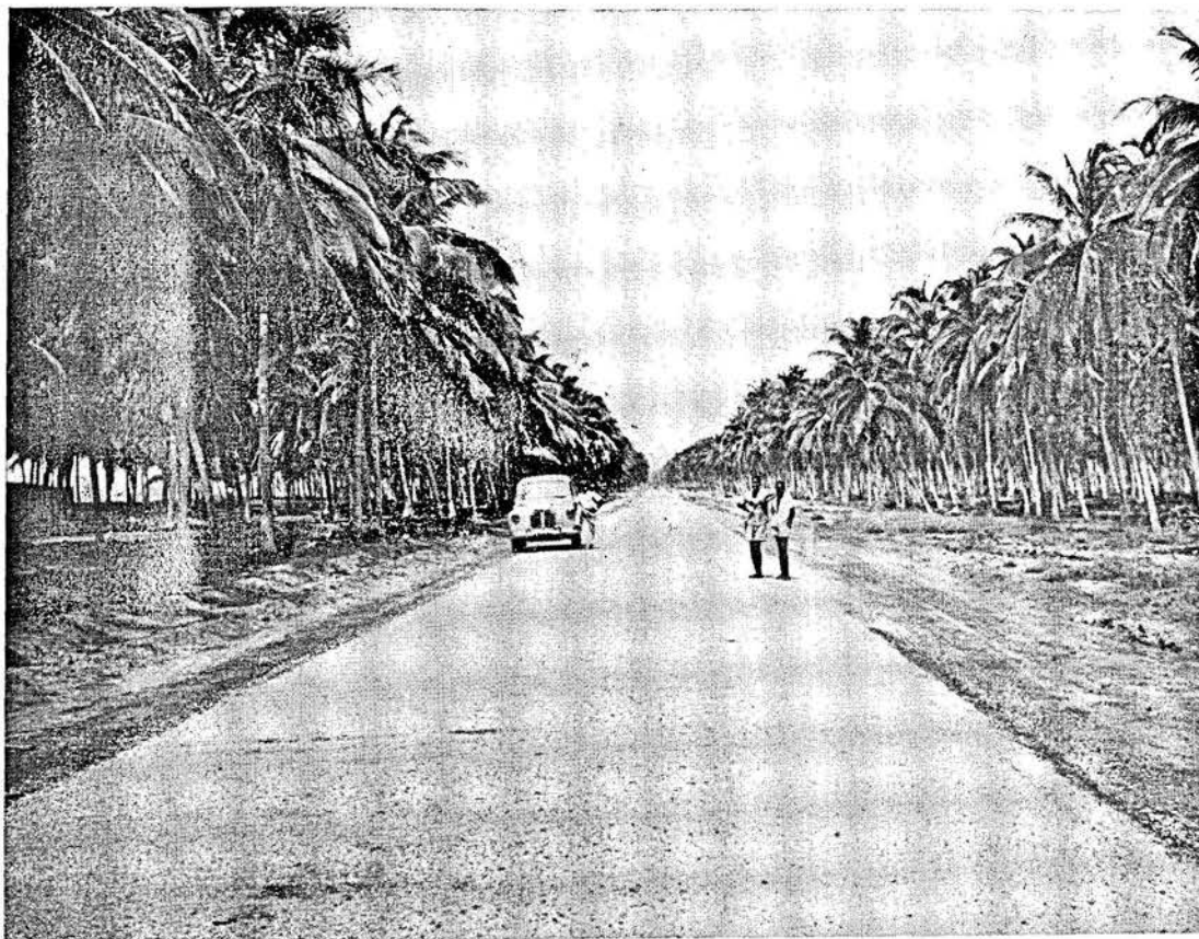
Route Lomé-Anécho après bitumage.
