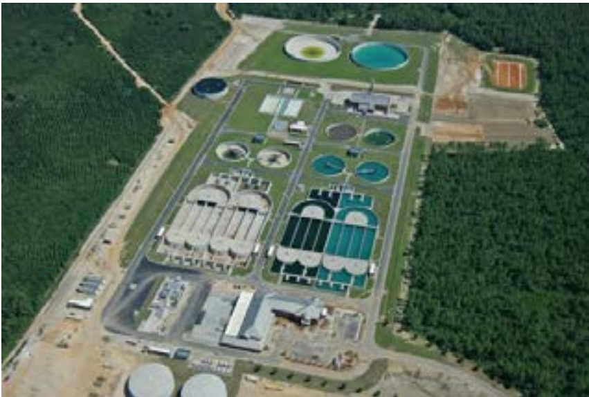
محطة معالجة المياه العادمة في مقاطعة إسكامبيا، فلوريدا (الولايات المتحدة)، التي دمرها إعصار إيفان، وتم استبدالها ونقلها بعيداً عن السهل الساحلي وبُنيت لتكون أكثر مرونة. وتعيّد المحطة الآن استخدام مياهها بنسبة 100%.
