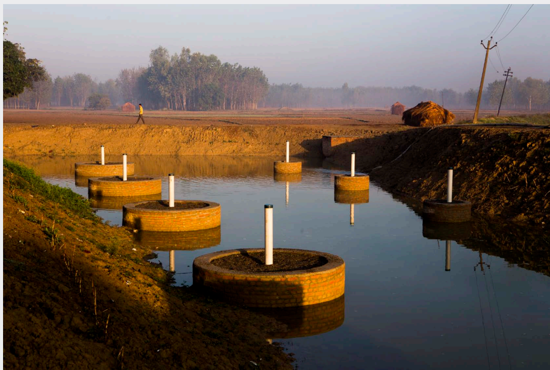
Figura | Mantener un estanque creado bajo UTFI
