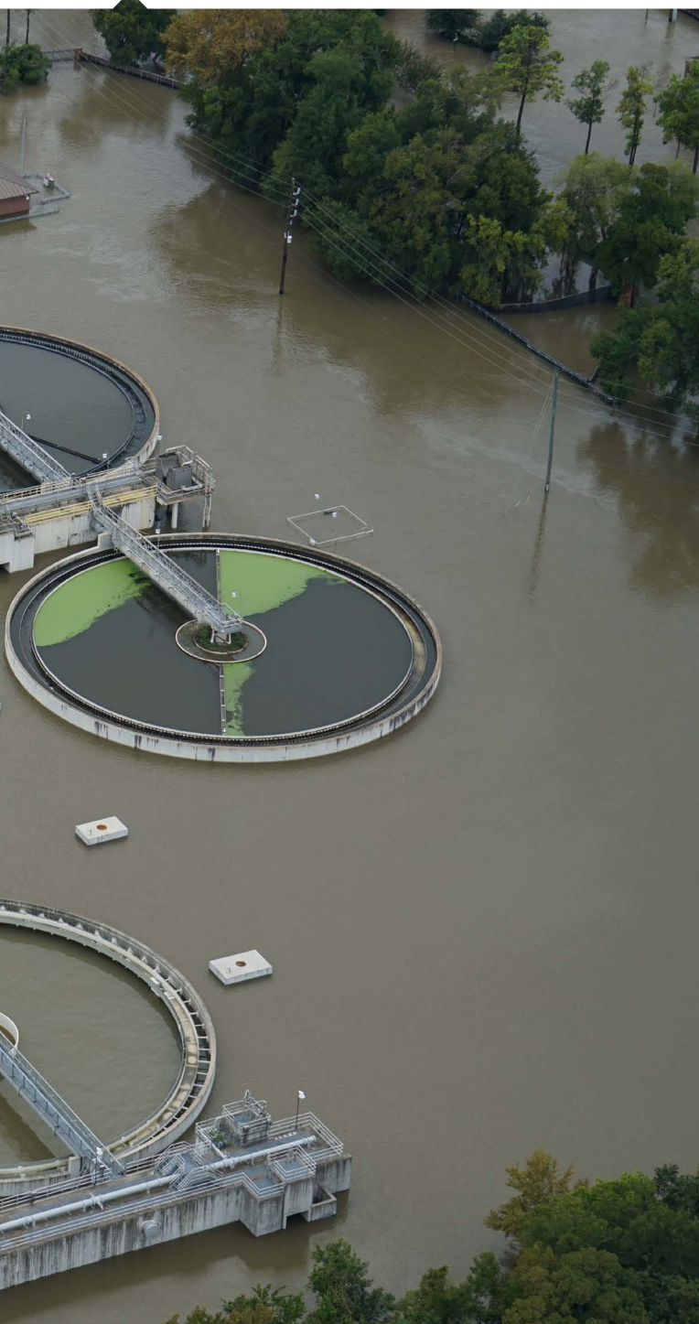
Planta de tratamiento de aguas residuales inundada después del huracán Harvey (EE. UU.)
