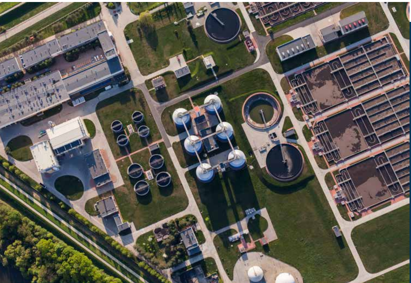
Vista aérea de una planta depuradora de aguas residuales Fotografía: © iStock.com/Mariusz Szczygiel
