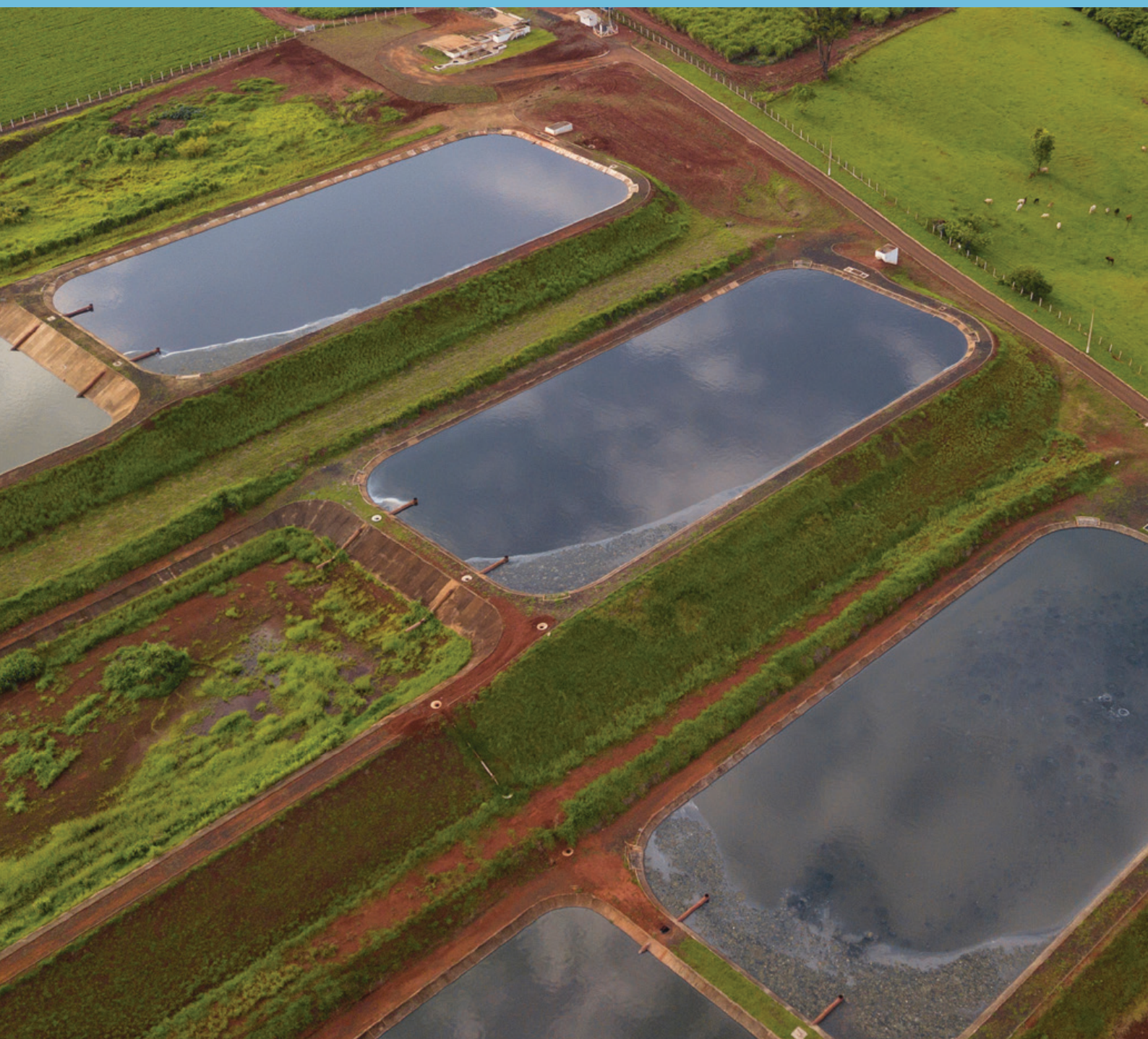
Vue aérienne du traitement des eaux usées.
