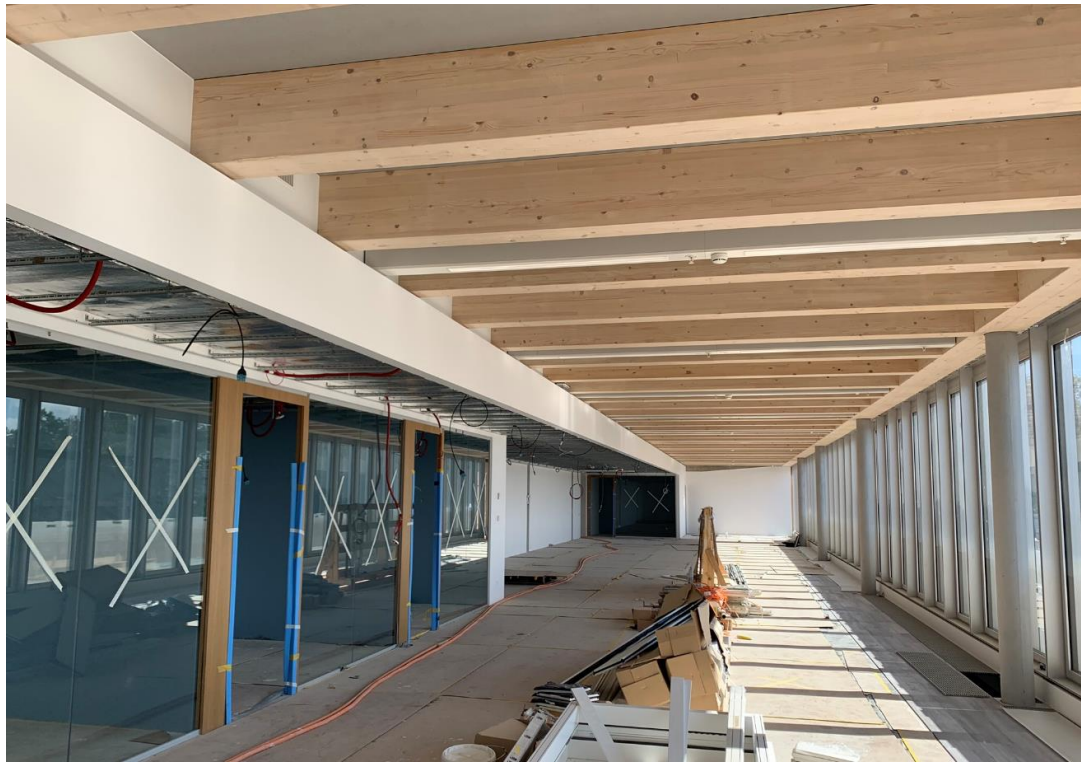
图三 2020年8月31日新建H楼一层的内部进度照
