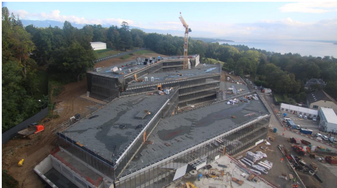
Рисунок II Ход строительства нового здания Н по состоянию на 31 августа 2020 года, вид снаружи
