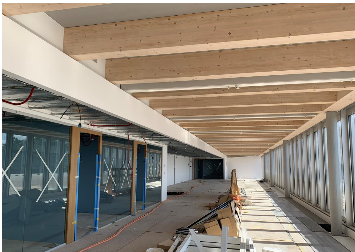
Рисунок III Ход строительства нового здания Н по состоянию на 31 августа 2020 года, интерьер уровня 1
