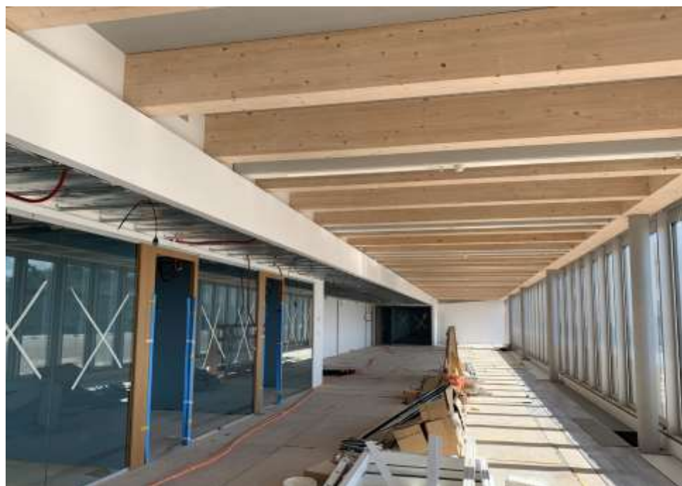
Figura III Fotografía de los progresos de las obras en el interior del nivel 1 del nuevo edificio H al 31 de agosto de 2020
