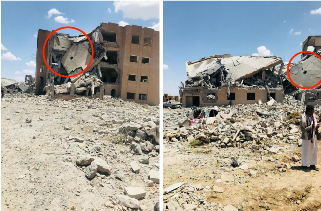
Figura XII Punto de impacto de las bombas aéreas en dos edificios diferentes del complejo del centro de estudios superiores de Damar
