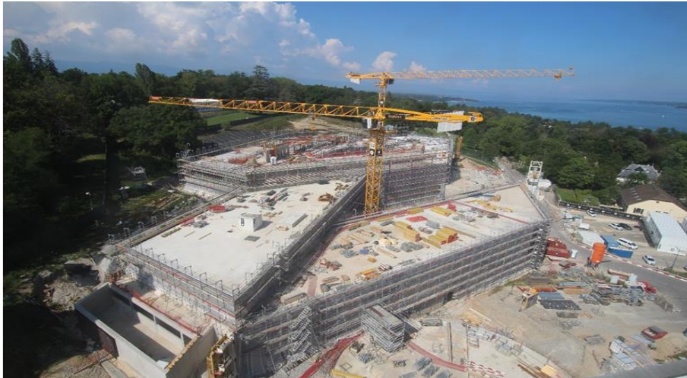
Figure III État du chantier de construction du bâtiment H au 31 août 2019
