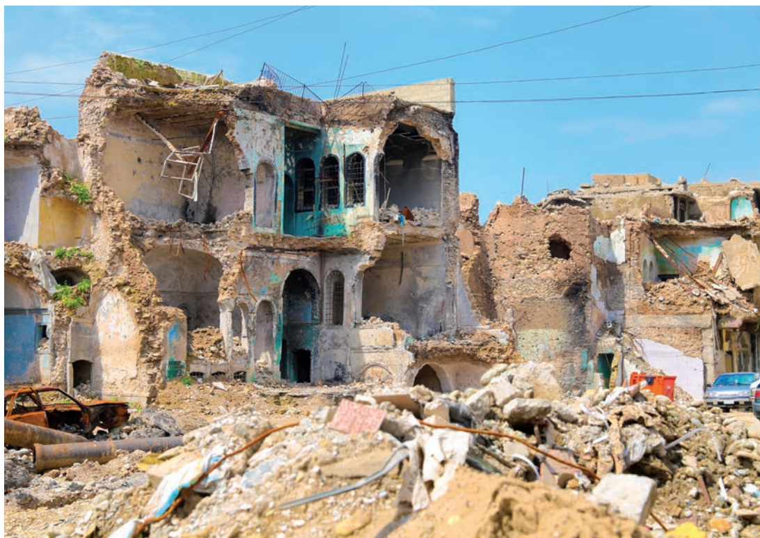
Mosquée, habitations et rues détruites durant la guerre à Mossoul
