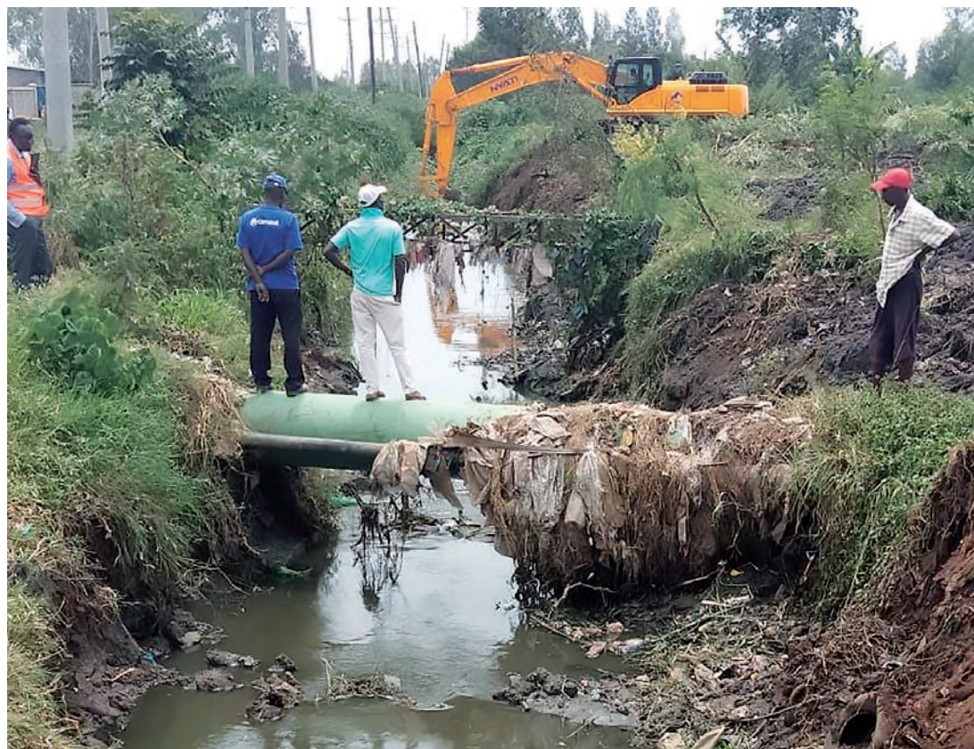
Labores de limpieza en Kisumu (Kenya) (Fuente: Patnaik/UNDRR, 2018b)
