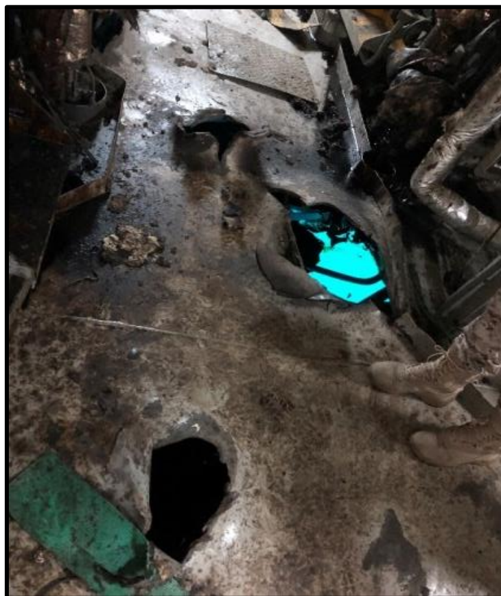
Imagen 3: Daños bajo la sala de depuradoras, en la sala de máquinas del Amjad.
