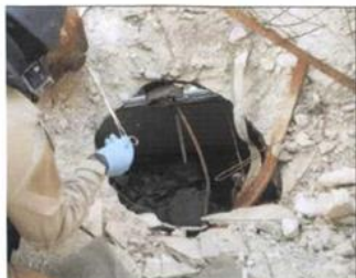
Форма и размеры образовавшейся пробоины соответствуют прониканию твердого тела в железобетонную преграду под углами 80-90 градусов от поверхности
