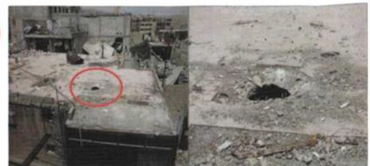
Присутствие более чем одной пробоины очень похожего внешнего вида в бетонных плитах наверху близлежащих зданий
