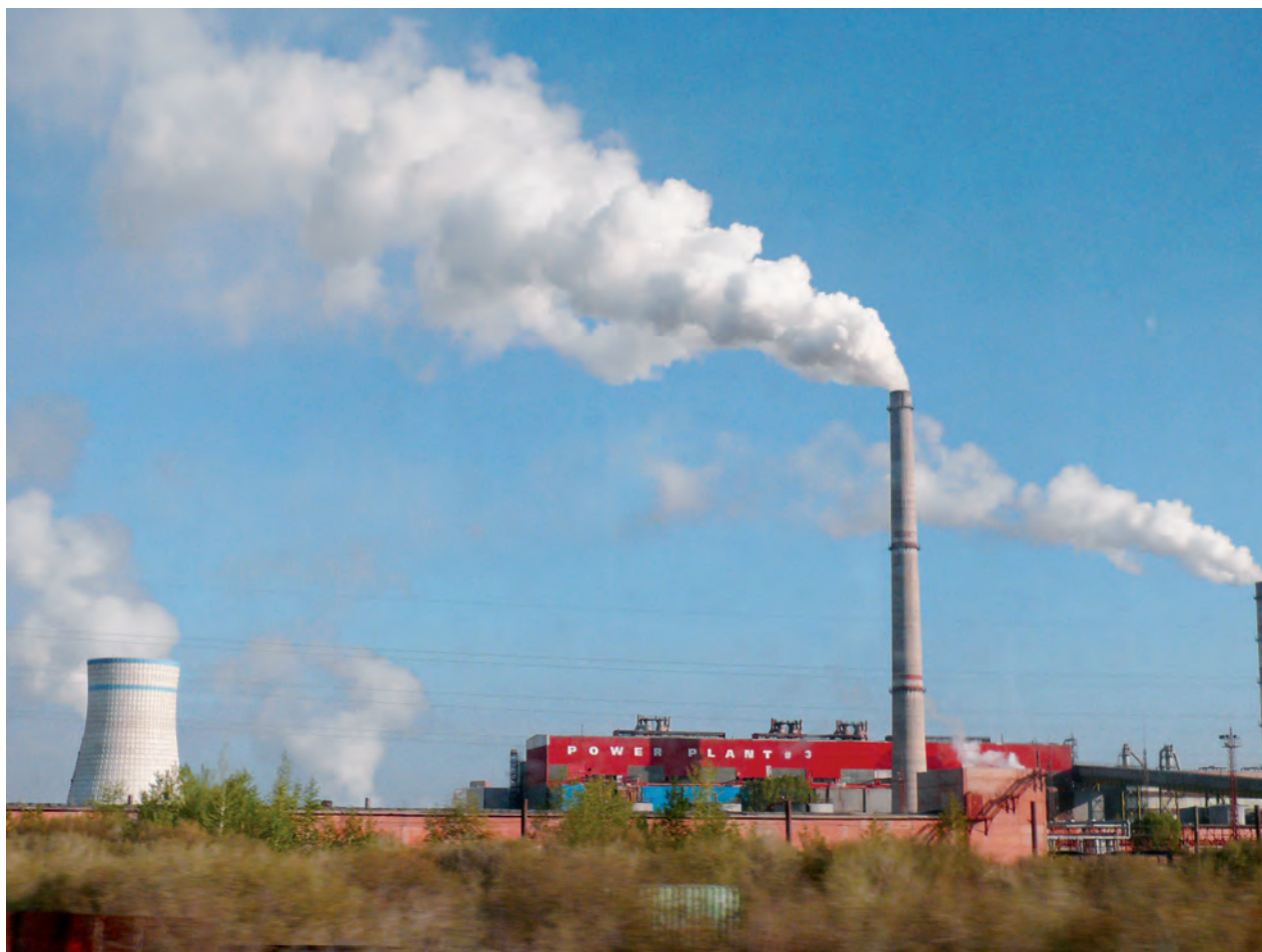
Фото зураг 8.1: Гуравдугаар Дулааны цахилгаан станц (ДЦС-3)
