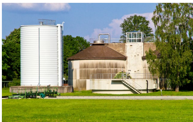
Source: Kläranlage - Faulturm, by Jürgen Fälchle.
