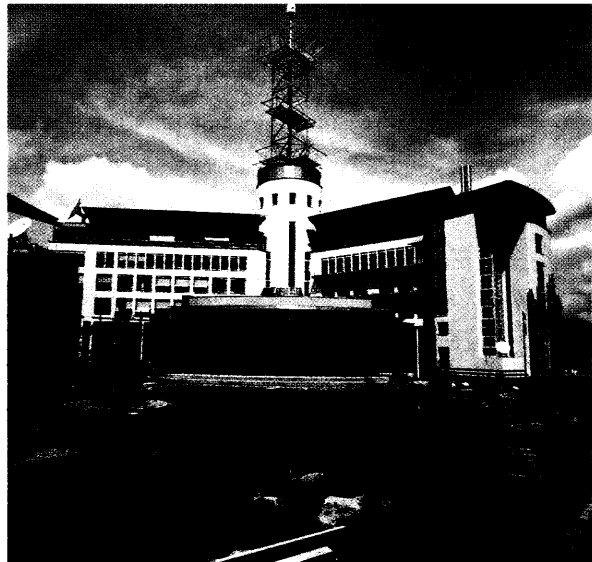
The building from the south La face Sud du Siège
