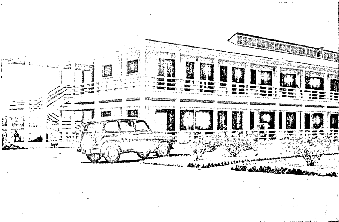
Hôpital central de Yaoundé. Nouveau bâtiment d'hospitalisation.
