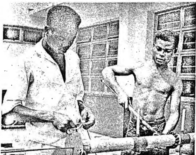
Montage d'un mât d'antenne, à Yaoundé.
