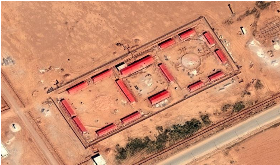
Figura 11 Imagen por satélite de Khadim, zona de entrada, edificaciones junto a carretera, marzo de 2017
